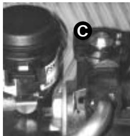
Réglage du débit du circuit chauffage. Il est nécessaire d'adapter ce débit en fonction du calcul de l'installation. La chaudière est livrée avec **la vis C du by-pass** intégré ouvert de 1/2 tour; en fonction des besoins effectuer la rotation de cette vis (ex. : visser pour fermer) pour adapter la hauteur manométrique disponible à la perte de charge de l'installation selon la courbe débit/pression (**p.14**).
