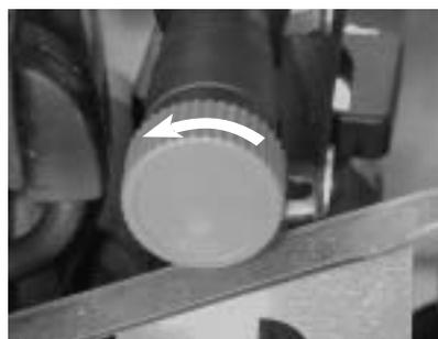
**5** Purger chaque radiateur jusqu'à écoulement normal de l'eau puis refermer les purgeurs.
