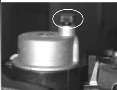
**4** Ouvrir le robinet bleu de remplissage situé sous la chaudière jusqu'à lire 2 bars sur l'indicateur de pression.
