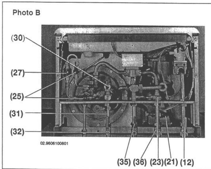
Les soupapes de sécurité (21) et (30) doivent être raccordées à une vidange selon la norme NF D 36-401.
